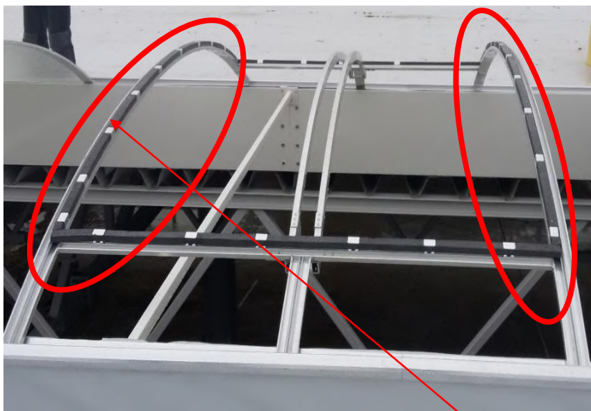
Rys. 42 Sposób rozmieszczenia konsol na łuku pająka.
