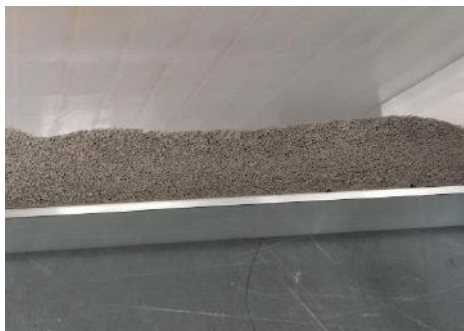
Rys. 34 Uszczelka rozprężna tuż po aplikacji
